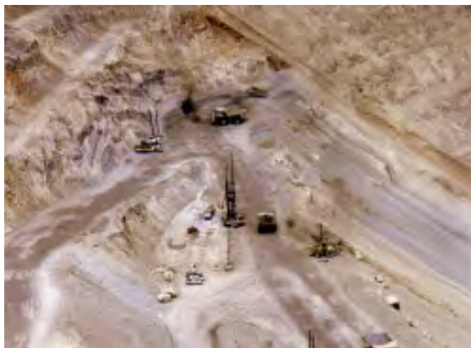
Gráfico 10. Toma Cercana de los Trabajos en el Pozo Principal de Tintaya.
