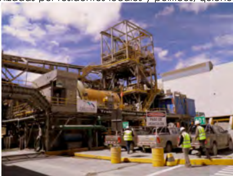
Gráfico 12. Porción de las instalaciones actuales de procesamiento de Tintaya (molienda).
